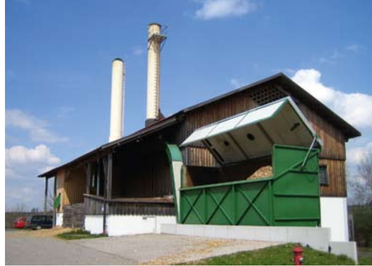
Das Biomasseheizwerk Sibyllenbad
