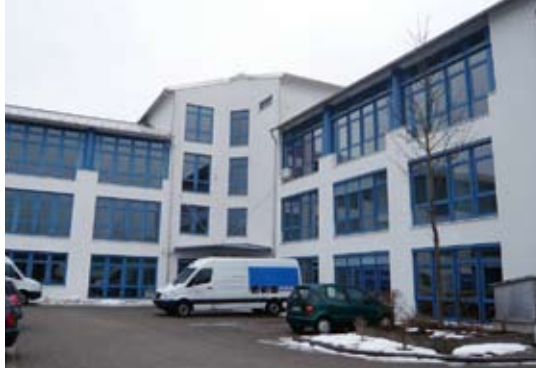
Das mit der Wärmepumpenanlage versorgte Gebäude in Perlach
